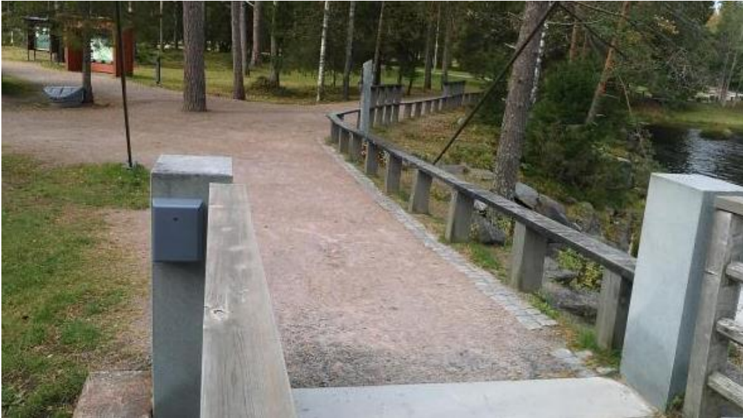
Kuva 12: Koitelin laskin on asennettu sillan päähän P-alueen puolelle.
