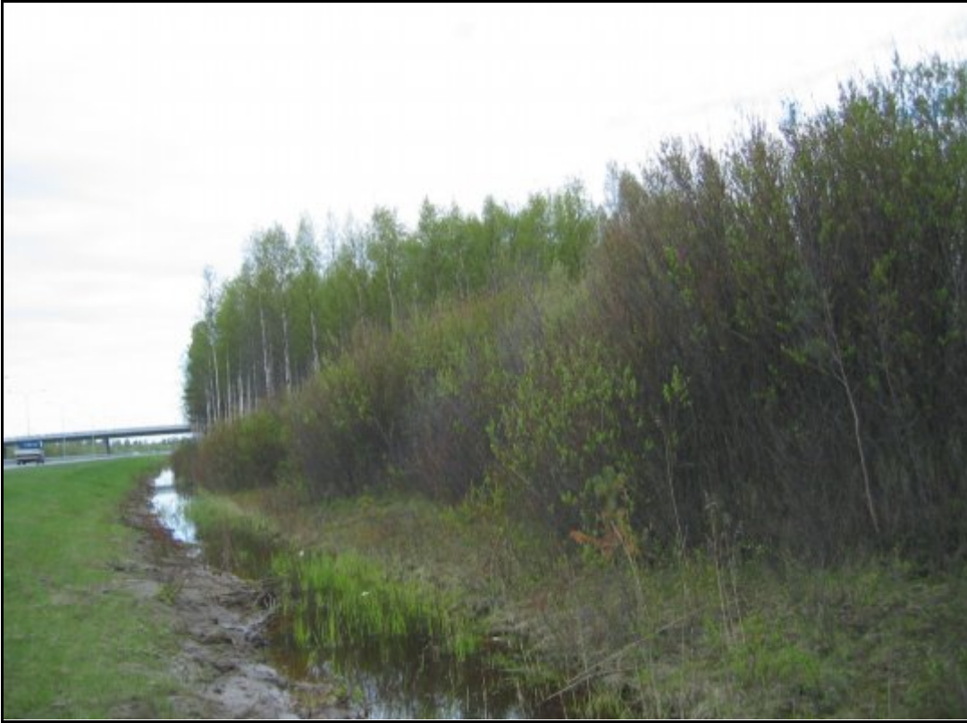
Kuva 2 Vesakko raivataan rampin kärjestä, puut jätetään.
