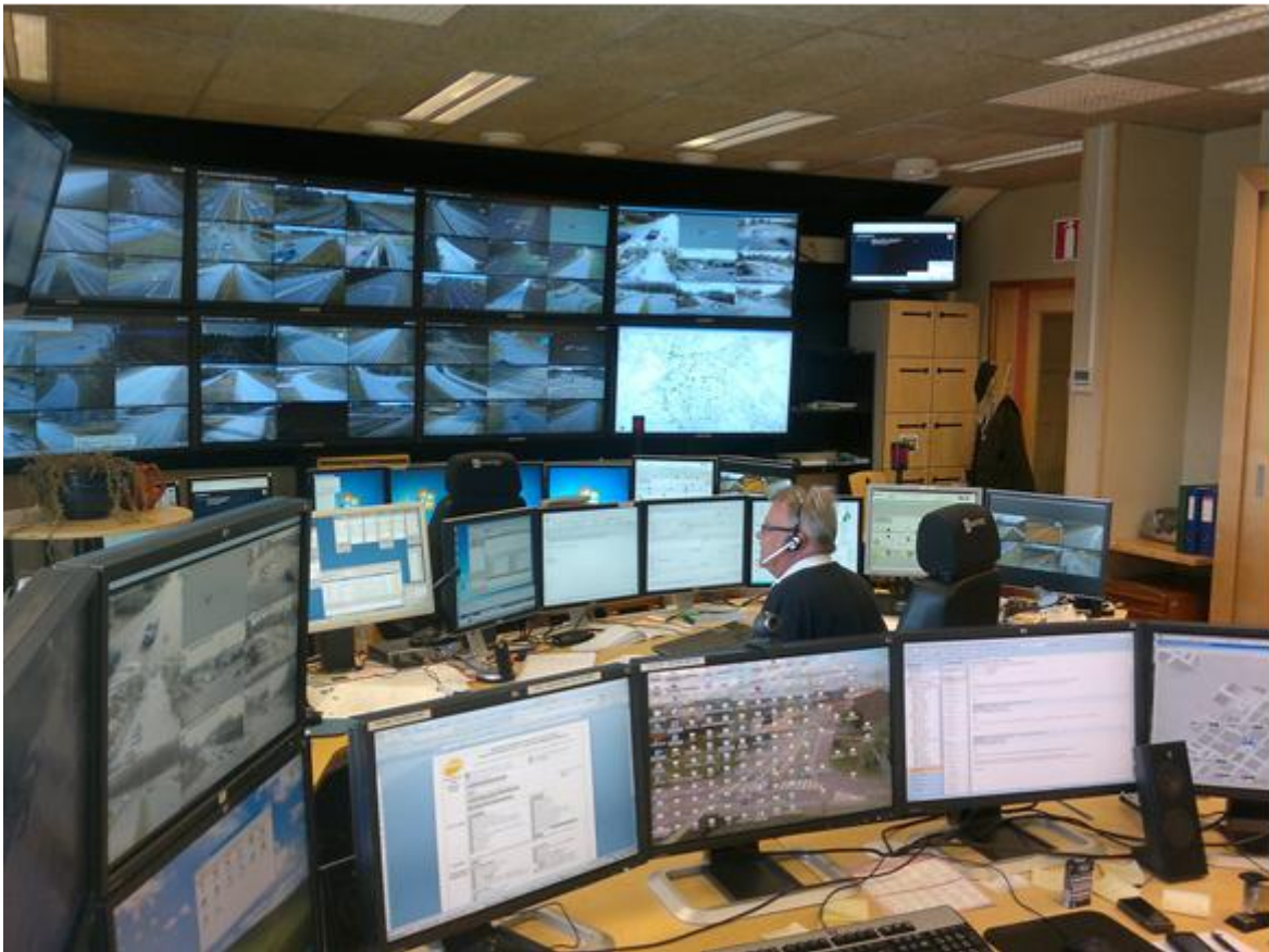
Kuva 24 Oulun seudun liikenteenhallintakeskus
